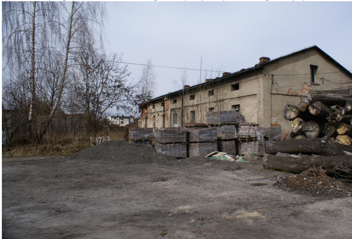
Rysunek 27 Budynki gospodarcze na terenie dawnego dworu (nieczynna wytwórnia wód gazowanych)
