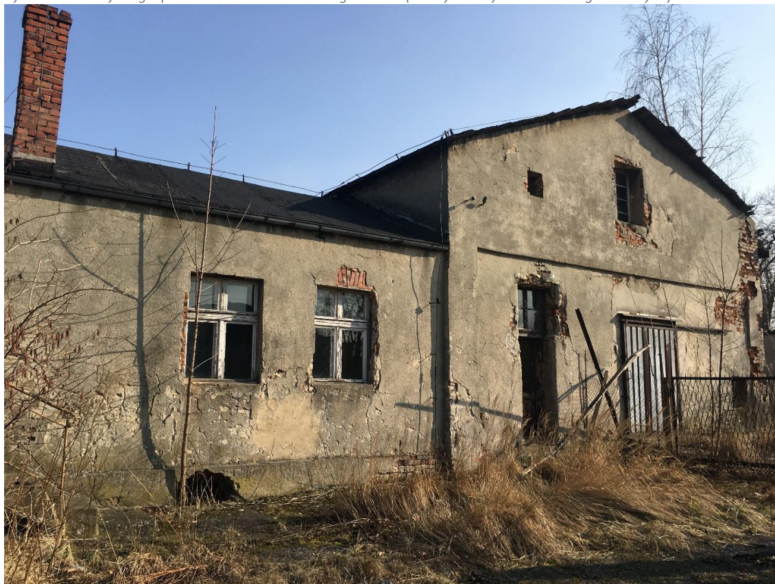
Rysunek 31 Budynki gospodarcze na terenie dawnego dworu (nieczynna wytwórnia wód gazowanych)
