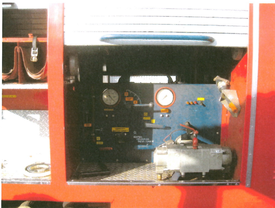
Fot. 8. Pulpit sterujący autopompą
